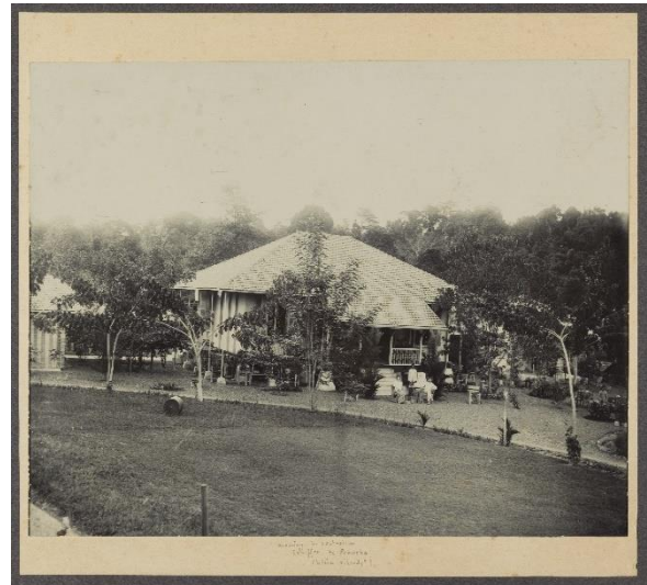
Foto 4. Rumah Kontrolleur di Penuba (Sumber: KITLV 34964, 1913)
